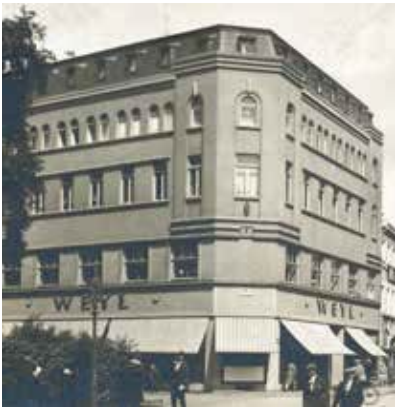
Abb. 5 — Modehaus Weyl, Südwall/ Ecke Hochstraße, um 1930.
