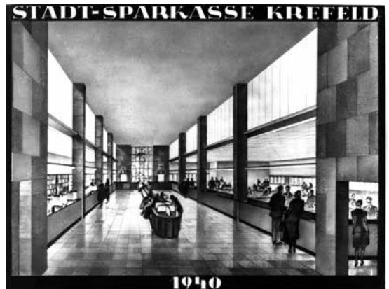
Abb. 92 — Schalterhalle der Stadtparkasse Krefeld, Friedrichstraße, 1940.
