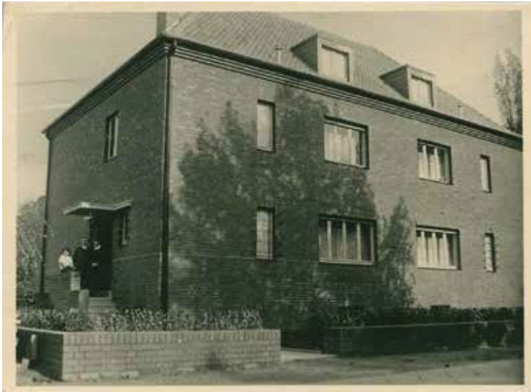
Abb. 64 — Haus Hindenburgstraße (Westparkstraße) 11.
