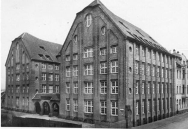
Abb. 43 — Fabrikgebäude Gompertz, Vater-Jahn-Straße 1–5.
